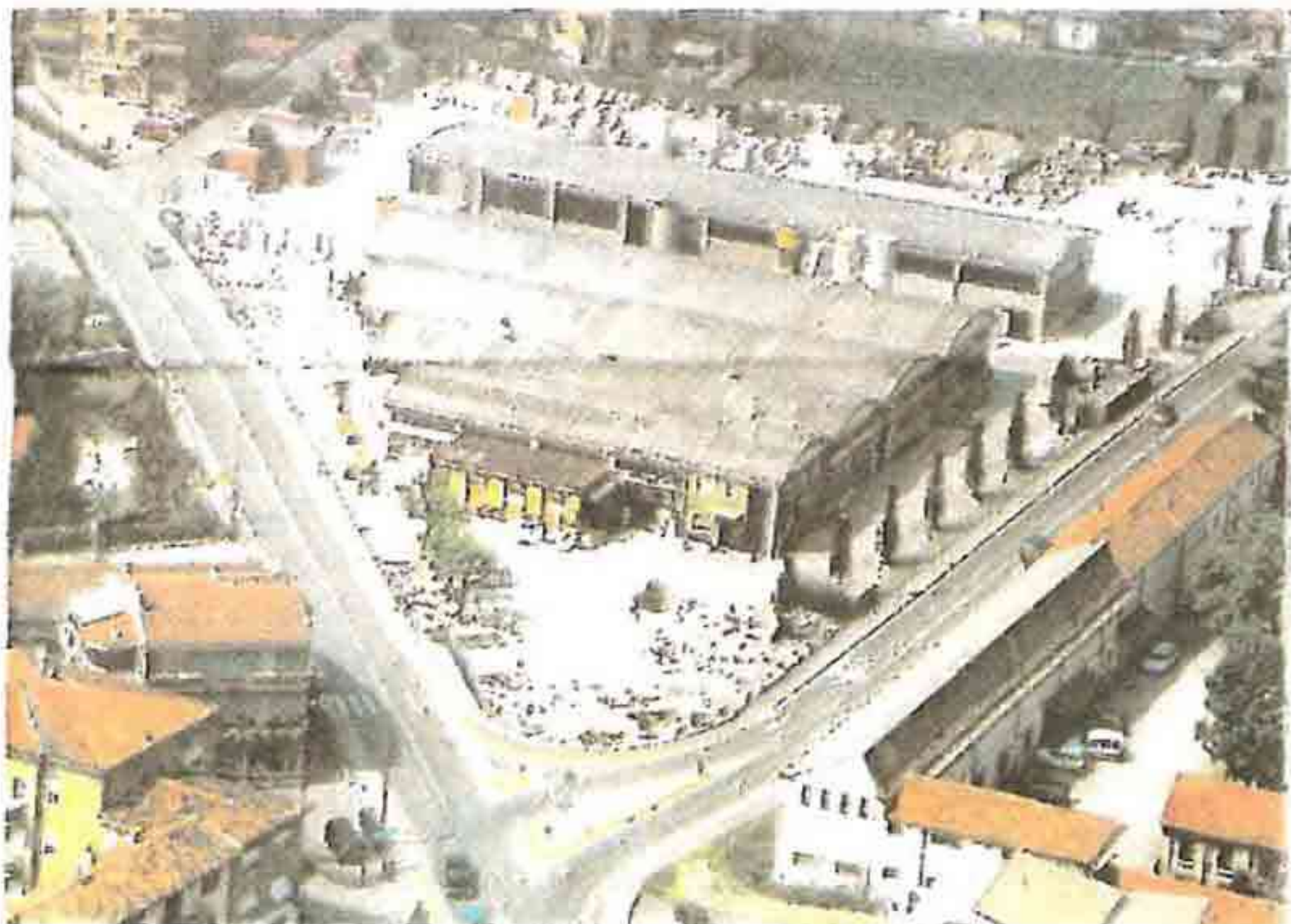
Veduta aerea del complesso CANTIERE TRI PLOK
